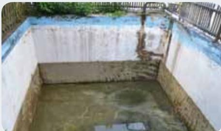
*Der undichte Löschteich am Marktplatz wird derzeit saniert.*
