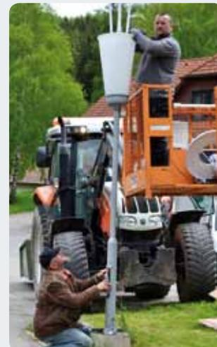
*Die Umbauarbeiten der Straßenbeleuchtungen auf die neue LED-Technik ist ebenfalls derzeit im Gange. Die Stromersparnis beträgt hier rund 70 Prozent.*
