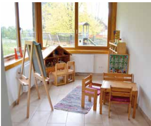
Hier wurde die ehemalige Dienstwohnung saniert und ein Zubau errichtet. Dabei entstanden folgende Räumlichkeiten: Therapieraum, Besprechungszimmer, Büro, Küche sowie ein Spielraum. Kosten € 60.000.-
