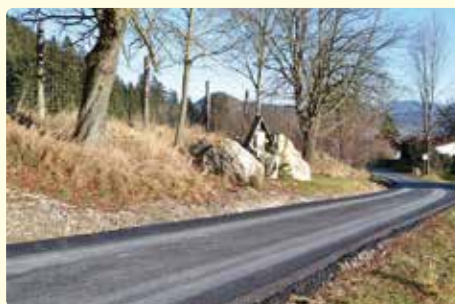
Asphaltierung eines Teilstückes des Karl im Hof Weges und Errichtung von Ableitungen für Oberflächenwasser.
