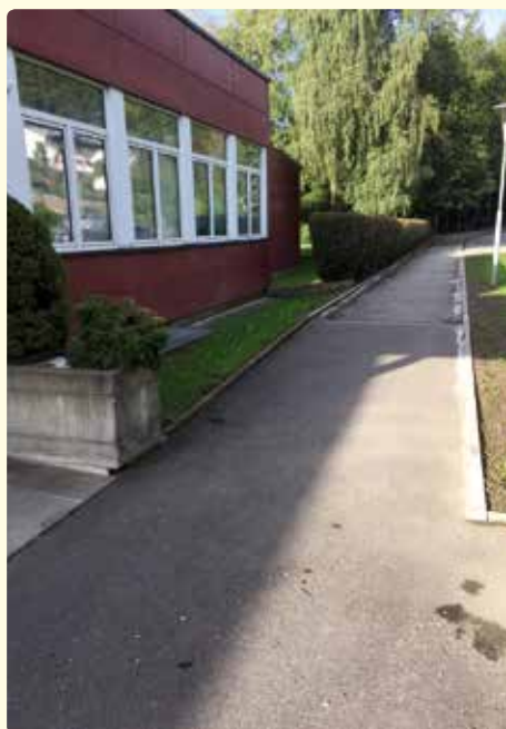
Randleisten beim Zugang zur Volksschule erneuert.
