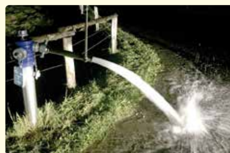
Wasserdruckmessungen an den verschiedensten Entnahmestellen durchgeführt.
