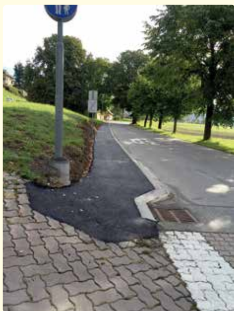
Gehsteig von Kreuzung Hochstraße - Hauptstraße zum Buswartehaus bei Gasteiner angelegt sowie zwei Laternen aufgestellt.
