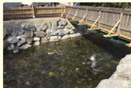
Verbau der Uferböschung an der Liesing im Mühlgraben im Bereich des Steges, Sanierung dieses Steges und Asphaltierung des desolaten Straßenstückes. Gleichzeitig wurden alle Leitungen, welche bisher am Steg angebracht waren (Trinkwasser, Gas und Telefon), mittels der Errichtung eines Dückers unter das Bachbett der Liesing verlegt.
