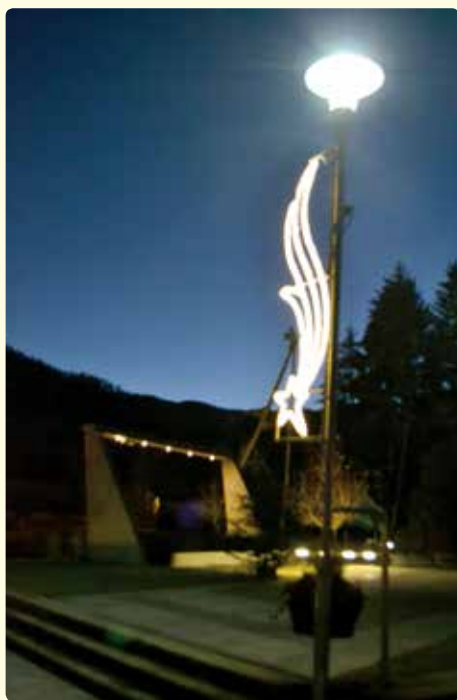
Errichtung einer Straßenbeleuchtung im Kreuzungsbereich des Marktplatzes und Erweiterung der Weihnachtsbeleuchtung.
