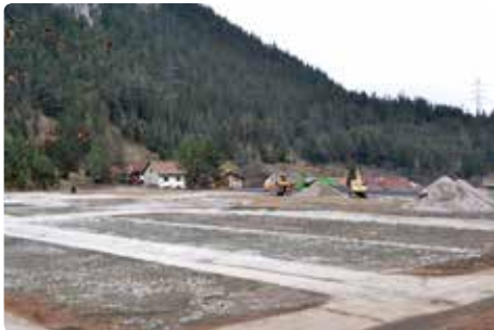
Das zukünftige Wohngebiet im Ausmaß von 27.605 m 2 nach dem Abriss der ehemaligen Betriebsanlagen.
