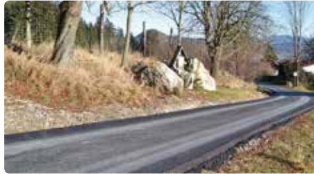
Asphaltierung eines Teilstückes des Karl im Hof Weges und Errichtung von Ableitungen für Oberflächenwasser.
