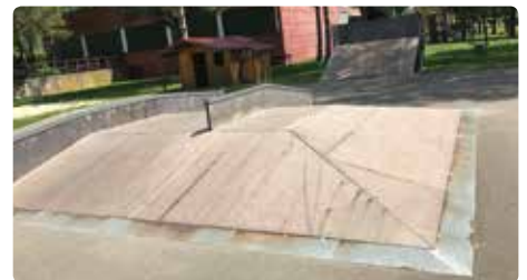
Reparatur des Skaterplatzes.
