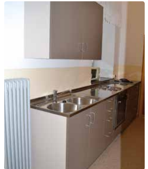
Im Kindergarten wurde im 1. Stock der Küchenblock sowie der Boden erneuert.
