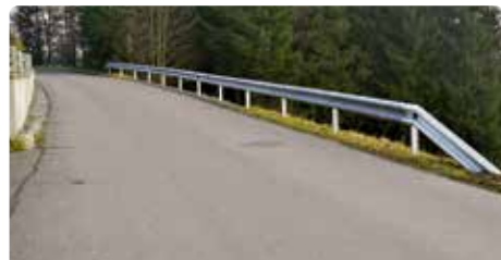
Abgemorschte Holzleitschienen wurden durch neue Metallleitschienen ersetzt und an der überaus gefährlichen Stelle auf der Hochstraße - im Bereich Otto Pobatschnig - wurde eine solche (siehe Bild) neu errichtet. Kosten € 21.000.-
