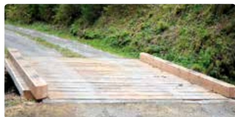
Erneuerung der Brücken im Fadelgraben und im Loos
