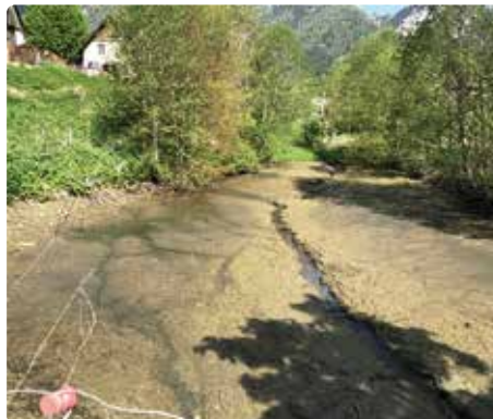
Sanierung des Löschteiches in Mochl.
