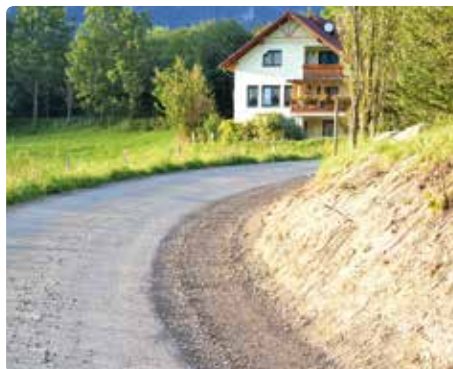
Der Dirnsdorferweg wurde an der Gefahrenstelle im Kurvenbereich verbreitert.
