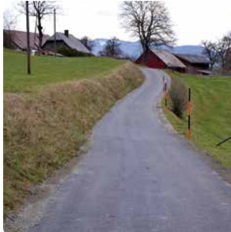
Asphaltierung eines Teilstückes des Kalvarienbergweges.
