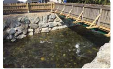
Verbau der Uferböschung an der Liesing im Mühlgraben im Bereich des Steges, Sanierung dieses Steges und Asphaltierung des desolaten Straßenstückes. Gleichzeitig wurden alle Leitungen, welche bisher am Steg angebracht waren (Trinkwasser, Gas und Telefon), mittels der Errichtung eines Dückers unter das Bachbett der Liesing verlegt.
