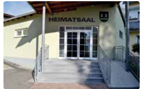
Übernahme des Heimatsaales mit 1. Jänner 2016 durch die Marktgemeinde. Aufgrund der vorgeschriebenen Maßnahmen und anstehenden Sanierungen der Isolierung und des Daches sahen sich die 8 Mitgliedsvereine nicht mehr in der Lage, die notwendigen finanziellen Mittel aufzutreiben. Bei der am 12. November 2015 durchgeführten außerordentlichen Generalversammlung wurde diese Übergabe an die Marktgemeinde von den 30 Delegierten der Mitgliedsvereine einstimmig beschlossen.
