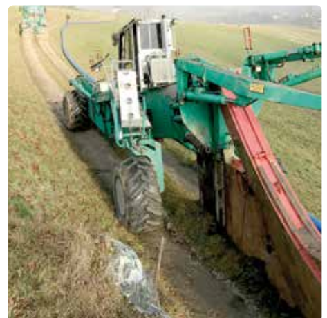
Um die Trinkwasserversorgung in Kammern auf die nächsten Jahrzehnte sicherzustellen, wurde eine neue Wasserleitung vom Hochbehälter in Dirnsdorf bis zum Anwesen Puchwein am Kalvarienbergweg mittels pflügen verlegt. Kosten mit einigen Sanierungsmaßnahmen für die Marktgemeinde: € 328.000.-
