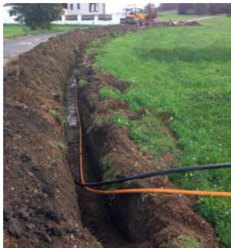
Ausbau des Breitbandkabelnetzes.
