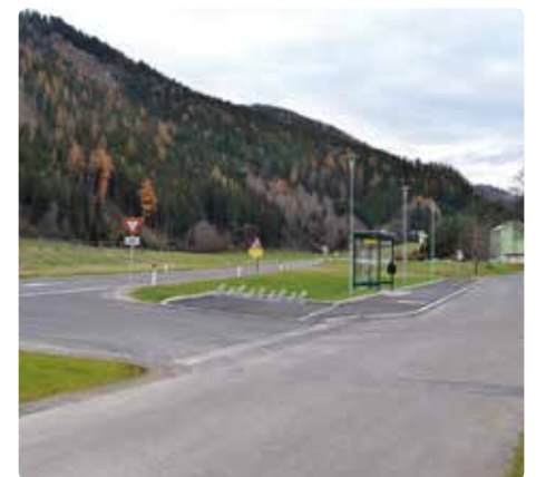
Errichtung eines neuen Busbahnhofes in der Bahnhofstraße in Seiz mit einem neu angelegten Fußgängerübergang im Kreuzungsbereich.
