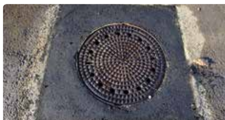
30 herausstehende Kanalschächte wurden in den verschiedensten Straßen saniert. (Problem beim Schneeschieben) Kosten € 26.000.-
