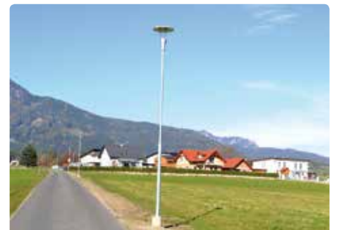
Errichtung bzw. Verlängerung der Straßenbeleuchtung beim Friedenweg und an der Hochstraße.
