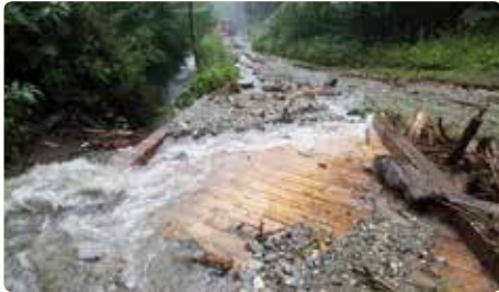
Sanierung der von den Unwettern im Juli dieses Jahres schwer beschädigten Wege in den Fadelgraben, Leims, Kammersbach und Wolfgrube.
