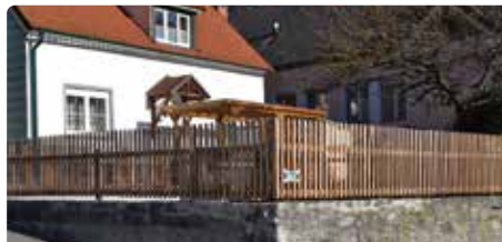
Errichtung eines neuen Holzzaunes beim Löschteich neben dem Marktplatz.
