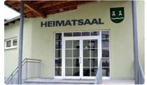
Im Heimatsaal wurden schwer entflammbare Vorhänge mit elektronischer Fernbedienung montiert sowie Erneuerungen an Türen und Montage von Panikverschlüssen durchgeführt. Kosten für die Marktgemeinde: € 17.000.-
