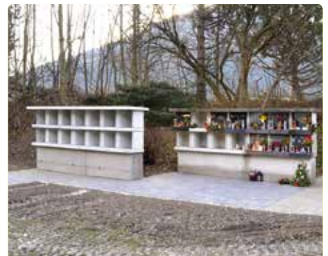
Errichtung einer weiteren Urnenwand im neuen Friedhof.
