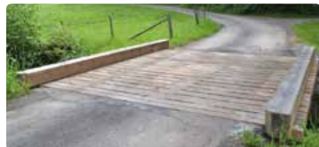
Die schon sehr desolante Brücke im Loos wurde erneuert.
