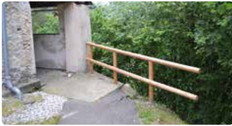
Das Geländer bei der St. Ulrichskirche wurde ebenfalls erneuert.
