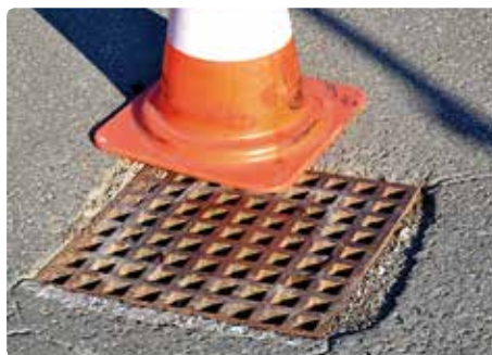
Sanierung von Wasser-Einlaufschächten.
