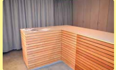
Umbau der Ausschank und Anbringung eines brandhemmenden Vorhanges im Schankbereich.
