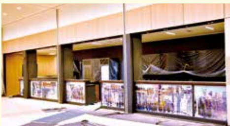
Neue Decke mit Zu- und Abluft, Heizung, neuer Beleuchtung und seitlich neuer Küchen- und Barbereich.
