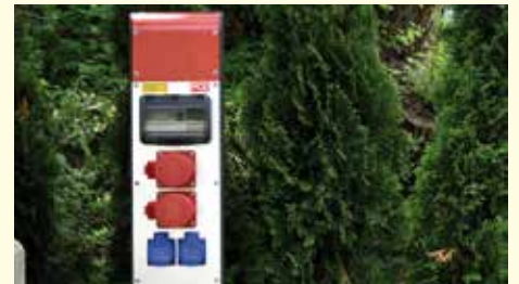
Stromanschluss: Nun gibt es im Eingangsbereich des neuen Friedhofes auch einen Verteiler für Stromanschlüsse.
