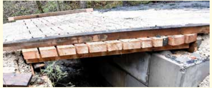
Generalsanierung einer Brücke in der Leims.
