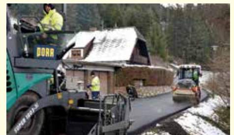
Asphaltierung des Kalvarienbergweges.
