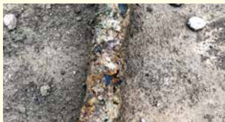
So schaute die alte Trinkwasserleitung aus.
