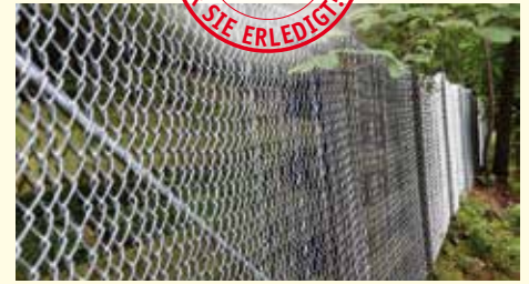
Auf einem Teilstück des Panoramaweges wurde der schon sehr desolante Steinschlag-schutz in Zusammenarbeit mit der Wildbach- und Lawinverbauung erneuert um die darunter liegenden Häuser und deren Bewohner vor größeren herunterrollenden Steinen zu schützen.
