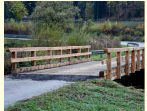
Neue Holzauflagen und neues Geländer bei der Brücke über die Liesing in den Fadelgraben.
