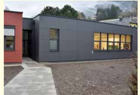
Rechts im Bild die neu errichtete Klasse für eine eventuelle Ganztageschule.
