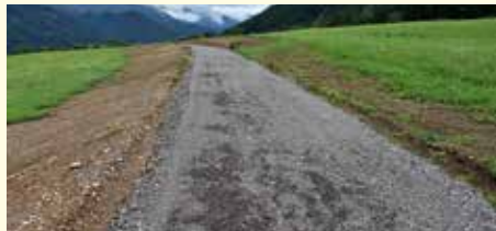
Wiederherstellung des Verbindungsweges vom Kalvarienbergweg (Anwesen Kain) nach Dirnsdorf. Dieser schon jahrzehntelange Gemeindeweg wurde wieder befahrbar gemacht und diente bei der Verlegung der neuen Trinkwasserleitung vom Kalvarienbergweg (Anwesen Puchwein) zum neuen Wohnpark als Ausweichstraße.
