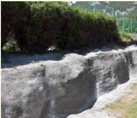
Steinmauer beim Sportplatzgelände mit Betonspritzung gesichert.
