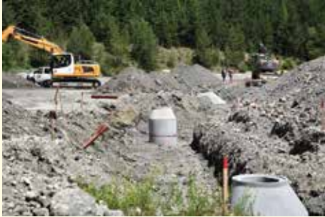
WOHNPAK: Hier wurden die Aufschließungsarbeiten für Trinkwasser, Abwasser und Strom durchgeführt.
