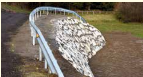
Steinschichtung am Kalvarienbergweg mit Leitschiene.
