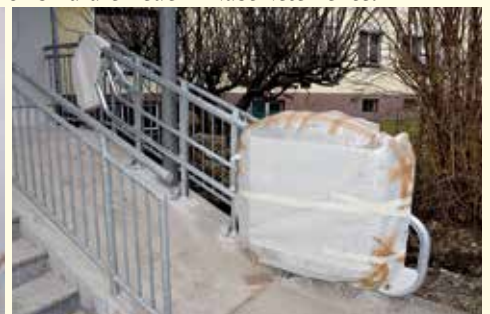
Behindertenlift beim Eingang.
