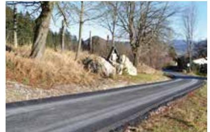
*Asphaltierung eines Teilstückes des Karl im Hof Weges und Errichtung von Ableitungen für Oberflächenwasser.*
