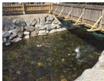
Verbau der Uferböschung an der Liesing im Mühlgraben im Bereich des Steges, Sanierung dieses Steges und Asphaltierung des desolaten Straßenstückes. Gleichzeitig wurden alle Leitungen, welche bisher am Steg angebracht waren (Trinkwasser, Gas und Telefon), mittels der Errichtung eines Dückers unter das Bachbett der Liesing verlegt.
