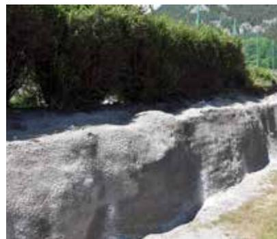
Steinmauer beim Sportplatzgelände mit Betonspritzung gesichert.
