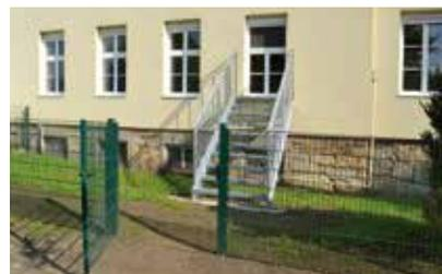
Neue Fluchttreie aus Stahlteilen vom Parterre und neuen Metallzaun mit Fluchttor.
