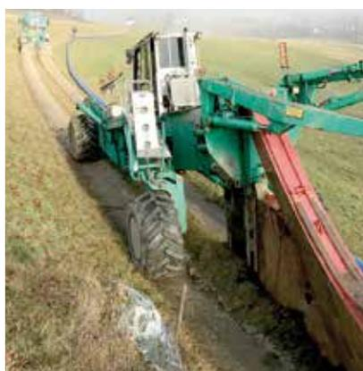
Um die Trinkwasserversorgung in Kammern auf die nächsten Jahrzehnte sicherzustellen, wurde eine neue Wasserleitung vom Hochbehälter in Dirnsdorf bis zum Anwesen Puchwein am Kalvarienbergweg mittels pflügen verlegt. Kosten mit einigen Sanierungsmaßnahmen für die Marktgemeinde: € 328.000.-
