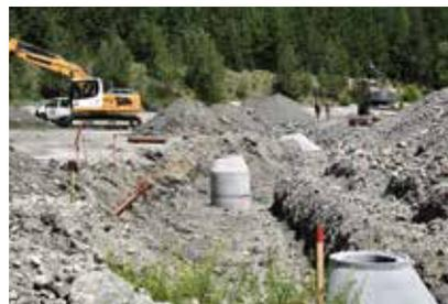
Hier werden gerade die Aufschließungsarbeiten für Trinkwasser, Abwasser und Strom durchgeführt.
